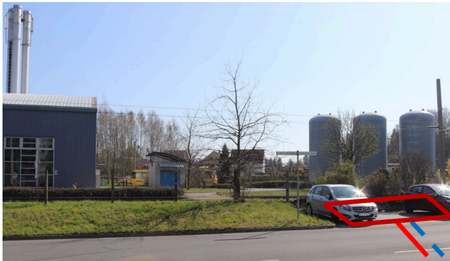
Abbildung 12: Schlesische Straße Parkplätze / Lage Schachtbauwerk
